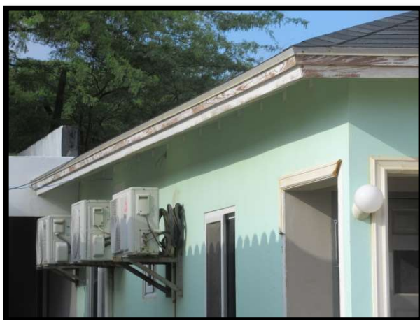
Onderhoud stoestand van de daken te Purun 109.
